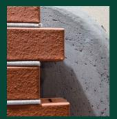
InsuCore ist ein mineralbasierter Ortschaum zur energetischen Sanierung von zweischaligem Mauerwerk. InsuCore wird durch kleine
